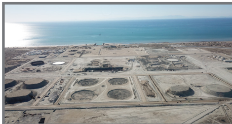
پروژه ذخیره سازی نفت خام مخازن جاسک در اسفند ۹۹
