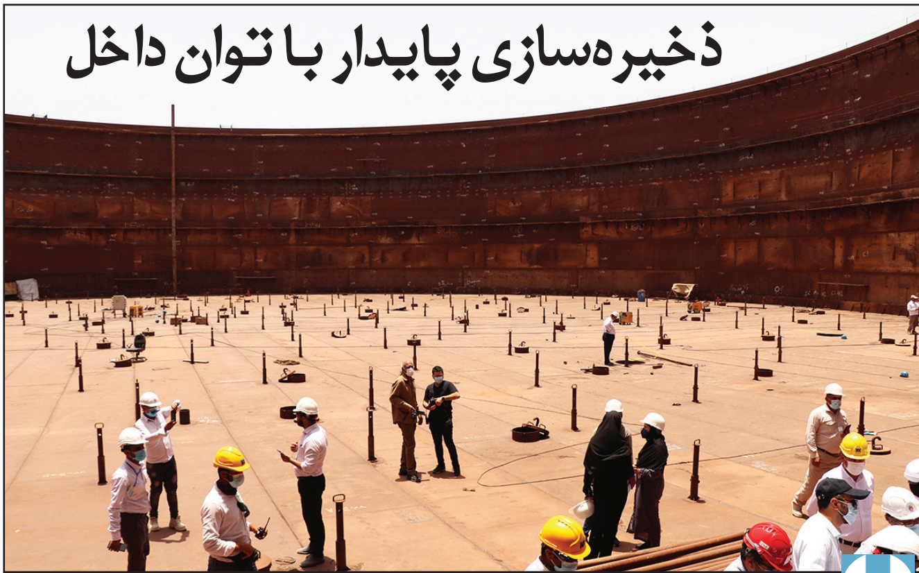
فضای داخلی مخزن ذخیره‌سازی ۵۰۰ هزار بشکهای نفت، در جاسک
