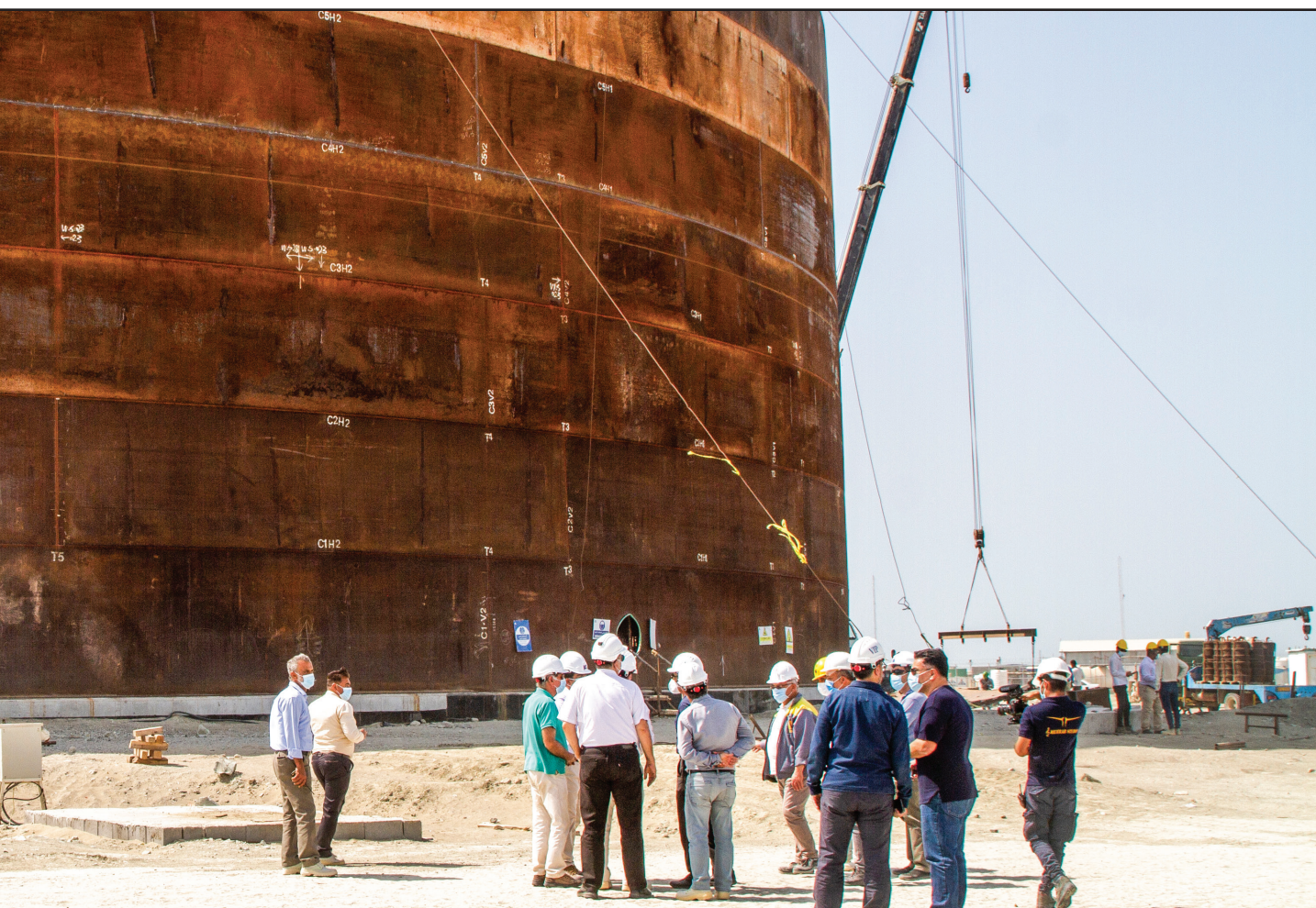
نمای بیرونی مخزن ذخیره سازی ۵۰ هزار بشکه‌ای نفت، در جاسک
