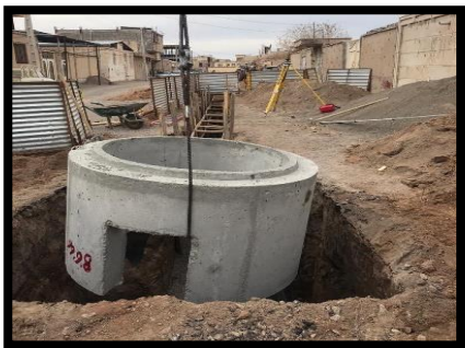
عملیات نصب منهول بتنی پیش ساخته
