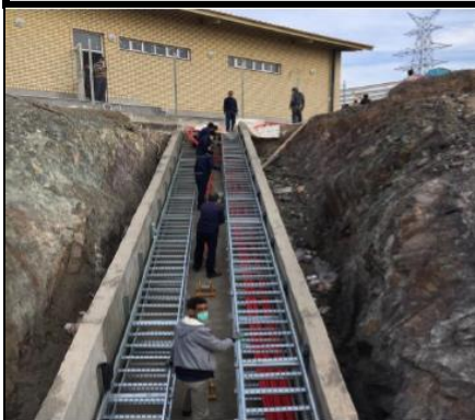
نصب سینی کابل ها و کابل کشی داخل ایستگاه پمپاژ
