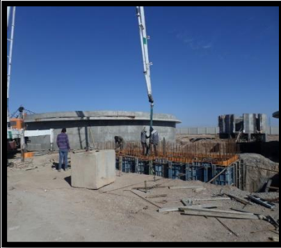
بتن ریزی دیوار حوضچه تقسیم هوادهی
