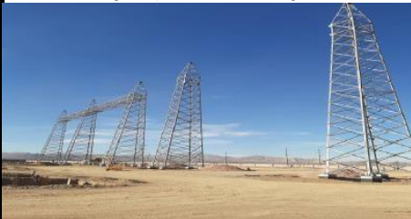
نصب سازه های گنتری
