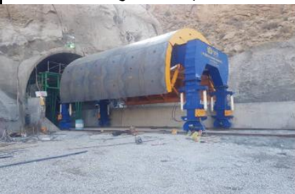
نمایی از ساختمان ضربه ایستگاه شماره 2
