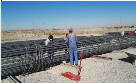
آرماتوربندی شمع های پل کیلومتر 132
