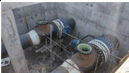
نصب شیرآلات حوضچه های ایستگاه پمپاژ شماره ۳
