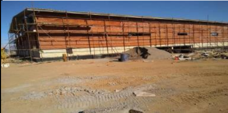
اجرای نمای ساختمان کنترل
