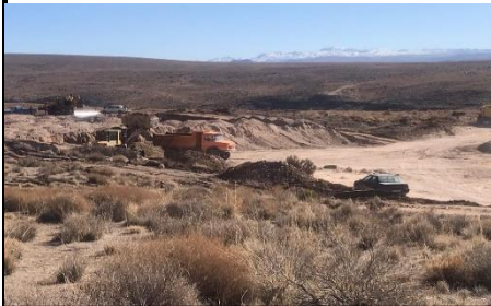
عملیات خاکبرداری کیلومتر 54 الی 55
