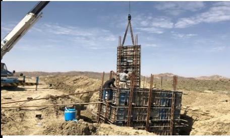
آرما تور بندی و قالب بندی حوضچه ها
