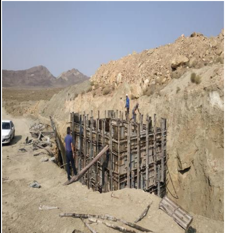
قالب بندی دیوار حوضچه 2+070
