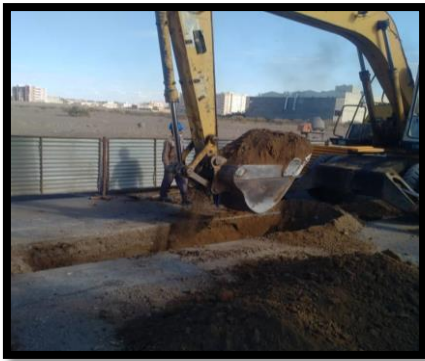
عملیات حفاری مسیر
