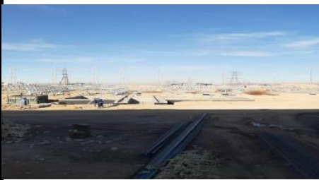
اجرای فونداسیون ترانسفورماتور
