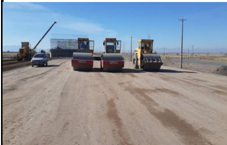
عملیات تراکم رمپ تقاطع در کیلومتر 15+000
