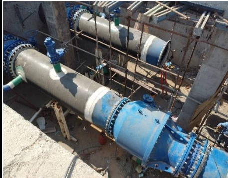
نصب شیرالات حوضچه flow control
