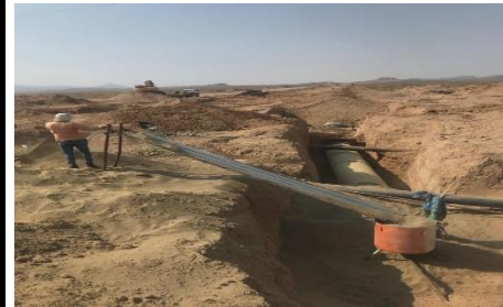
عملیات پایپ جکینگ راه آهن و ماسه رانی داخل غلاف کیلومتر 2+200
