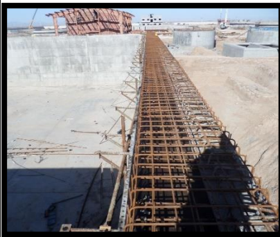
آرماتوربندی پیاده روی هاضم هوازی
