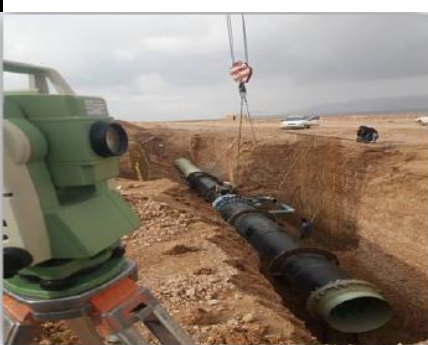
نصب لوله فولادی و شیر آلات حوضچه
