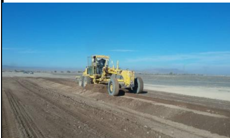
پخش و رگلاژ کیلومتر 126+000
