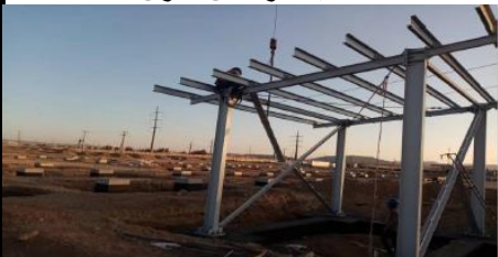
اتمام نصب BCR ها
