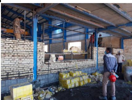
اجرای ساختمان اداری تلمبه خانه ایستگاه پمپاژ شماره ۴
