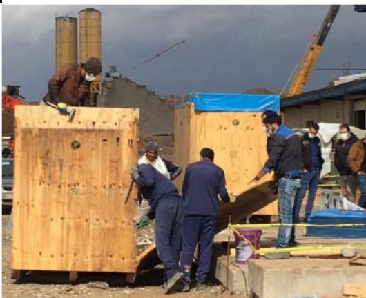
نصب ترانس های VFD
