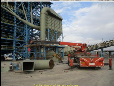
نصب ماشینهای بین نواحی کوبینگ ۵،۶ و ۷
