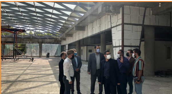
▲ بازدید از مراحل احداث اتومال / شهریور ۱۴۰۰
